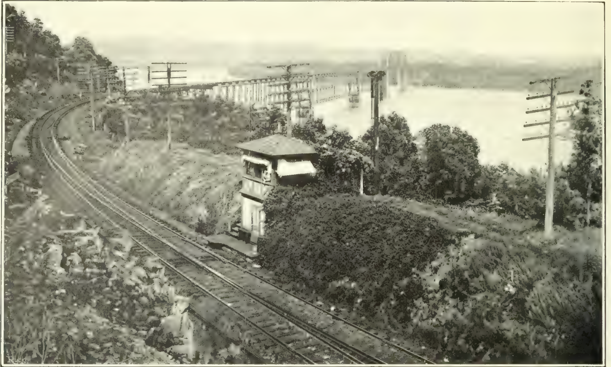
SUR LA LIGNE DE BALTIMORE-OHIO. — Très avancée dans l'industrie du fer, l'Amérique emploie presque exclusivement cette matière pour ses ouvrages d'art, qui sont, presque toujours, des modèles du travail de l'ingénieur.
